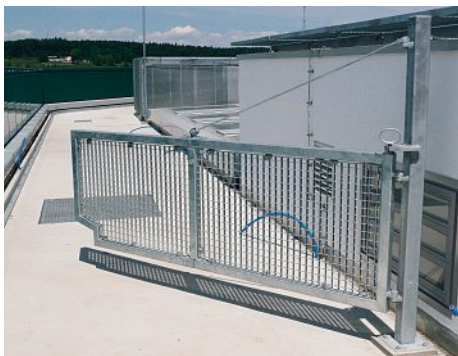
Gitterrosttore regeln den Durchgang der rund 4 Meter breiten umlaufenden Gehfläche. Les portes en caillebotis régulent l'accès à la coursive large d'env. 4 m.
