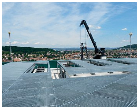
Die technischen Aggregate sind alle auf elegante Art und Weise geschützt. Les équipements techniques sont tous élégamment protégés.
