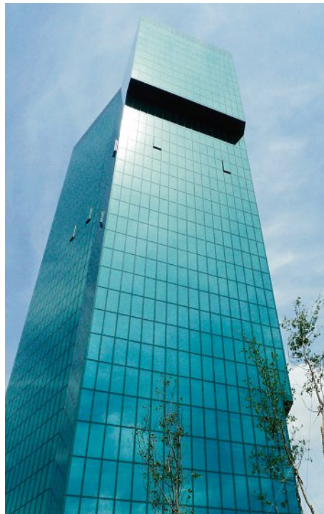
120 Meter hoch über Zürich befindet sich die beachtliche Gitterrostplattform.
