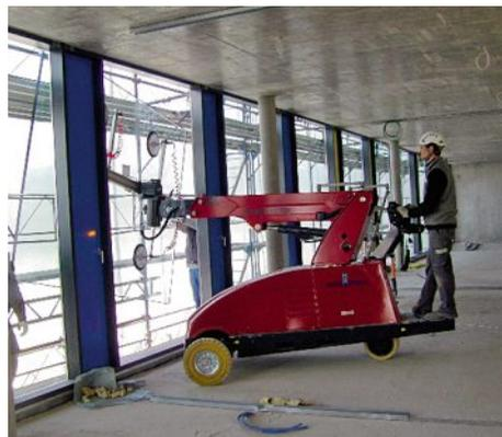
Der GL 500 mit einer Tragkraft von 500 kg im Einsatz. Alle Bewegungen in drei Ebenen werden elektronisch überwacht.
