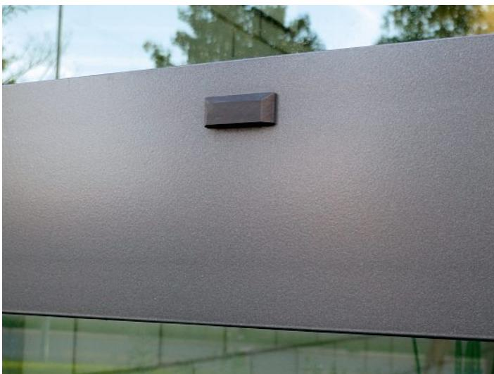
Die Entwässerungsöffnungen sind ausreichend zu dimensionieren und auf jeden Fall zu entgraten und anzusenken.
