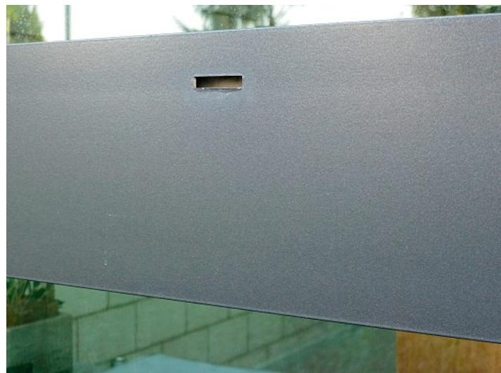
Abgedeckte Entwässerungsöffnungen sehen besser aus als offene, lassen sich aber schlechter reinigen.
