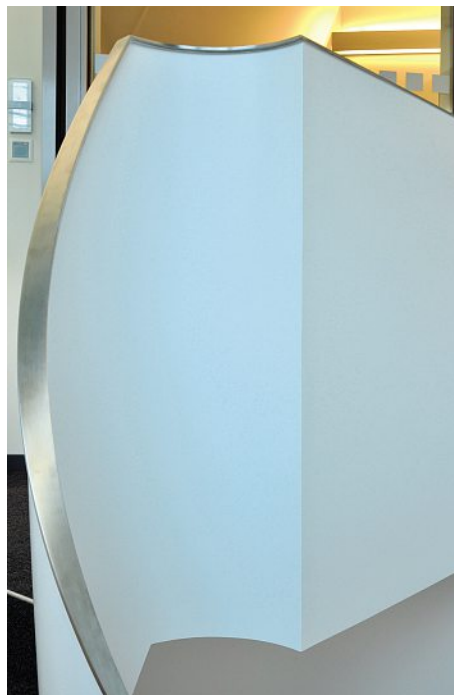
Der Bodenring und die tragenden Wangen sind aus Stahlblech 20 mm ausgeführt.
