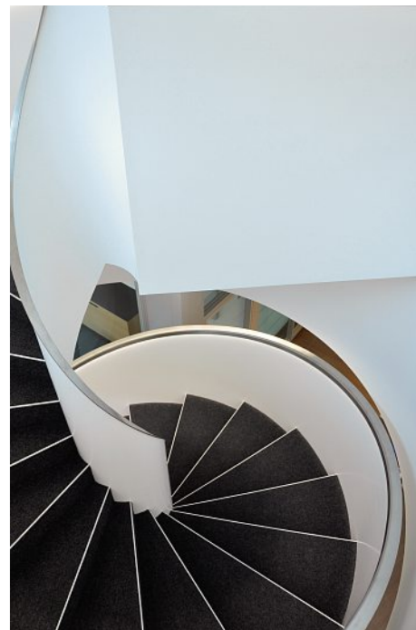
Ein Edelstahlhandlauf mit LED-Leuchten weist den Weg.
