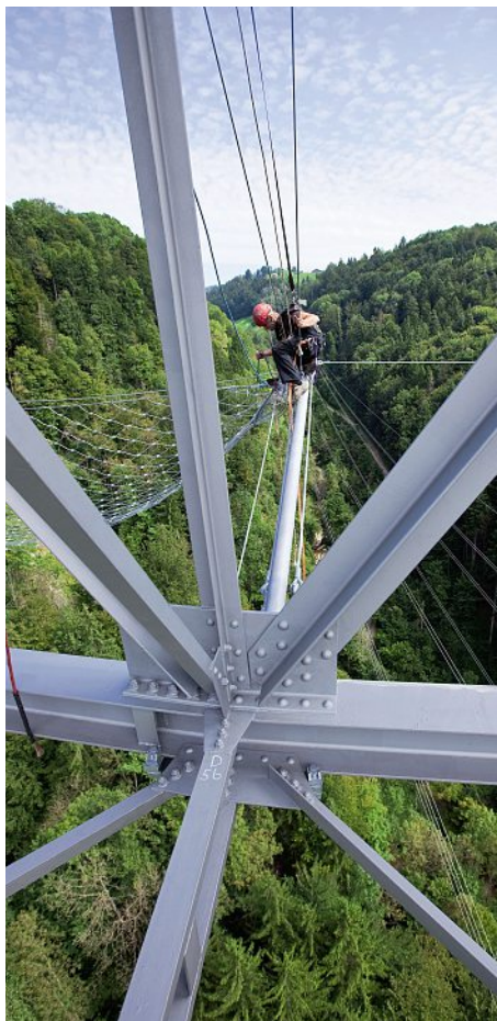
Montagen in schwindelnder Höhe. Montage à une hauteur étourdissante.
