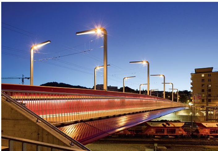
Der Brückenquerschnitt besteht aus zwei je 4,5 Meter breiten Hohlkastenträgern.
