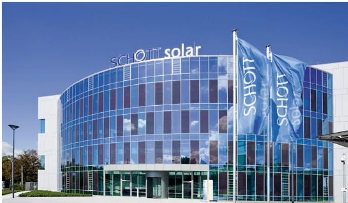
82 SCHOTT-Solar-Module des Typs «ASI thru» mit insgesamt 10 kW sind in die Fassade integriert, auf dem Dach sorgt eine 26-kW-Photovoltaik-Anlage für Strom.
