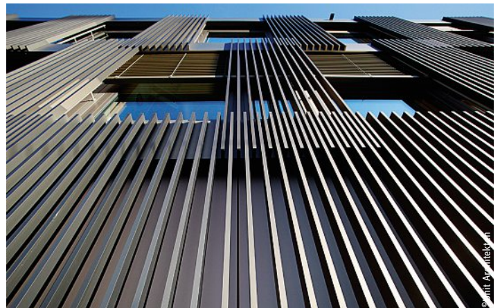
Das Ineinandergreifen der Lisenenprofile im Brüstungsbereich generiert einen gewissen verspielten Charakter. Les profils de pilastre emboîtés dans la zone du parapet créent une touche de fantaisie.
