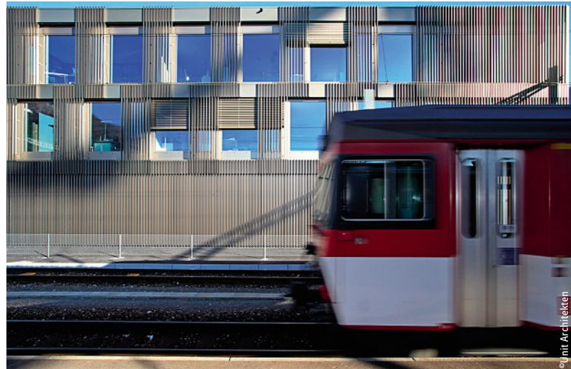
Auf der den Geleisen zugewandten Südwest-Seite ist der innere Fassadenmantel im Erdgeschoss als vorgehängte, hinterlüftete Blechfassade ausgeführt. Sur le côté sud-ouest, donnant sur les voies ferrées, le manteau de façade intérieur au rez-de-chaussée est une façade en tôle suspendue, ventilée à l'arrière.
