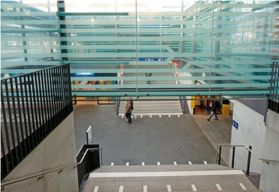
Die schweren Gläser über den Treppenaufgängen sind frei hängend und nur über die Glashalter befestigt. Les lourds panneaux de vitrage au-dessus des départs d'escaliers sont autoportés et simplement fixés par les plots de montage.
