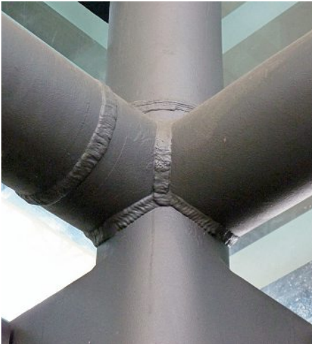
Die Bauschweissungen sind im MAG-Verfahren mit einer Fülldrahtelektrode DW A50 von 1,2 mm Durchmesser vorgenommen worden.
