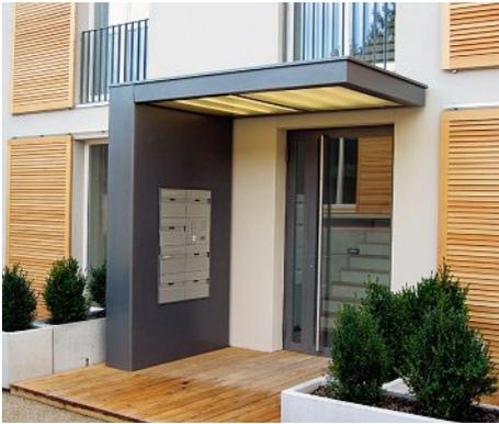
Die integrierte Beleuchtung schafft eine angenehme Lichtstreuung durch die Acrylplatte. L'éclairage intégré diffuse une lumière douce à travers la plaque de verre acrylique.
