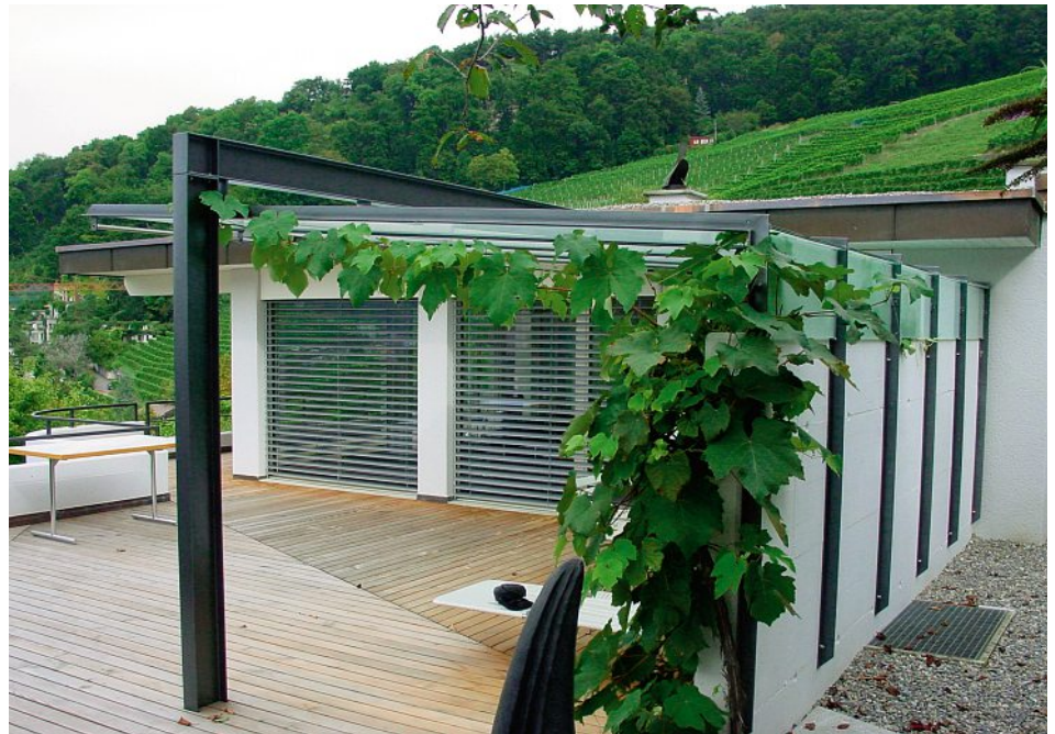
Die Dachsparren hängen am stählernen Tragjoch.
