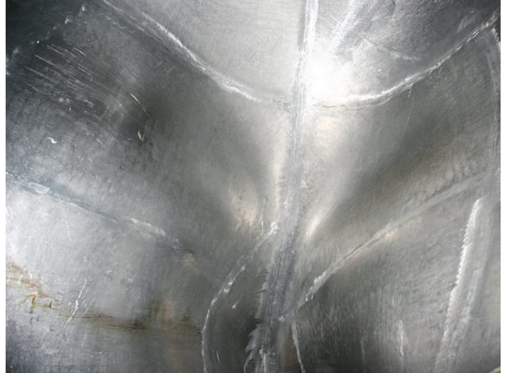
Die Schweissnähte sind geglättet und sauber verschliffen. Les cordons de soudure ont été poncés et polis proprement.
