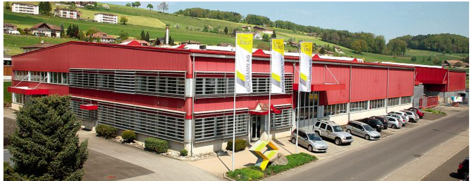
Die Bühlmann AG in Wauwil L'entreprise Bühlmann AG à Wauwil
