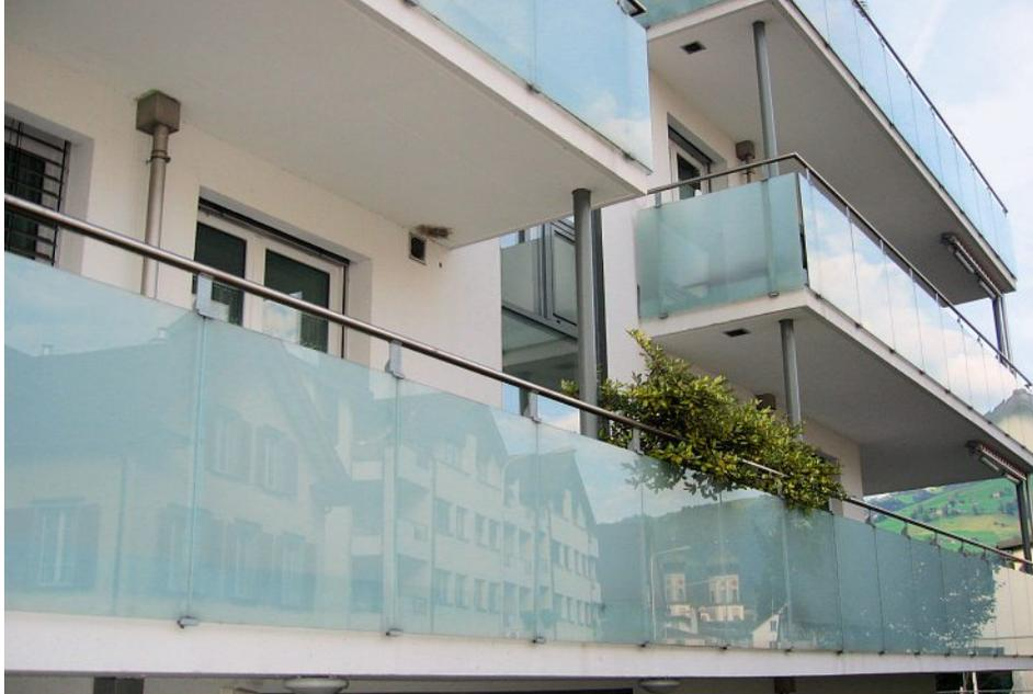
Dieses Geländer ist mit Glashaltern Typ 1 ausgebildet, welche den Pendelschlagtest bei weitem nicht bestanden haben.
