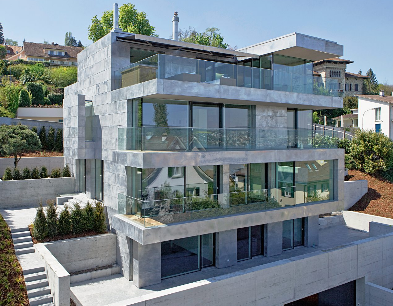
Die Gesamtansicht zeigt die Sonnenseite des Hauses. Der 60-cm-Raster sorgt für horizontal wie vertikal gut durchgestaltete Proportionen. La vue générale montre le côté ensoleillé de la maison. Le quadrillage de 60 cm assure de bonnes proportions horizontales et verticales.
