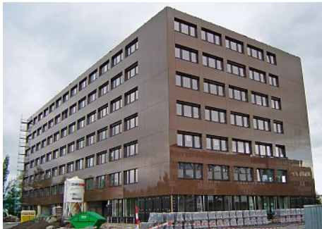
Für das Dienstleistungszentrum «Prisma II» in Steinhausen sind 2500 m 2 Fassadengläser SSG geklebt worden. Pour la façade vitrée du centre de services « Prisma II » à Steinhausen, 2500 m 2 de VEC ont été collés.
