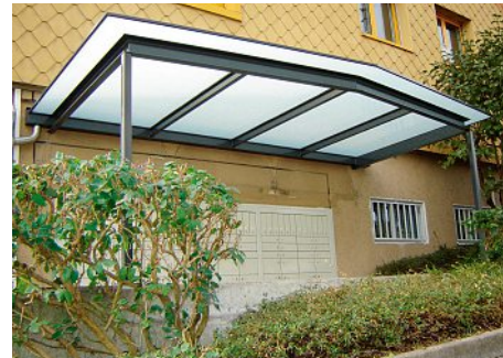
Das Glas wurde stoss- und deckleistenfrei im Werk verklebt und als Einheit mit dem Kran am Zielort aufgesetzt. Le verre a été collé sans joints ni couvre-joints à l'usine et mis en place au lieu de destination à l'aide d'une grue.
