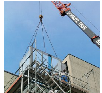
Vorsichtiges Herunterlassen und Aufsetzen. Abaissement et mise en place minutieux.
