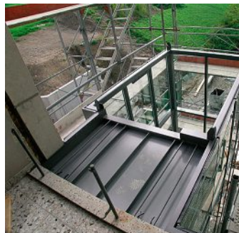
Blick in den Gerüstschaft mit den gestapelten Elementen. Vue du centre de l'échafaudage avec les éléments superposés.
