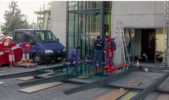
Die Verglasung erfolgte am Boden. La pose des vitrages a été réalisée au sol.
