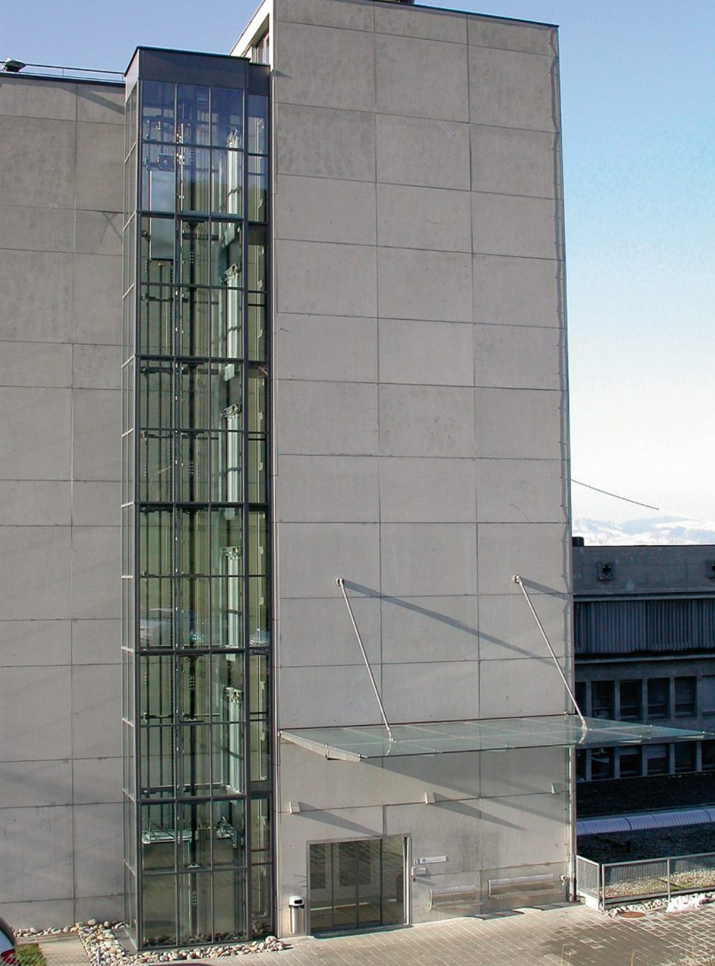
Der angebaute, verglaste Liftturm erstreckt sich über sechs Stockwerke. Rechts das gläserne Vordach.
