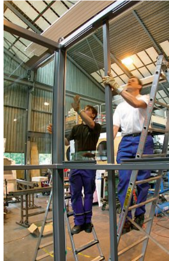
Die sechs geschosshohen Einzelelemente werden im Werk verglast. Les six éléments à hauteur d'étage sont vitrés à l'usine.
