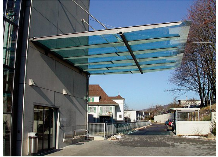
Das Vordach mit seinen Schwertunterzügen und dem Stabilisierungsrohr. L'avent avec ses traverses transversales et le tube stabilisateur.
