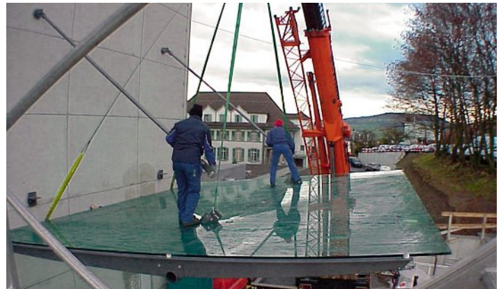
Beim Anheben des Daches. Die Zugstangen sind zum Einhängen bereit. Lors du levage du toit. Les barres d'ancrage sont prêtes à être suspendues.
