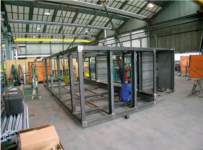
Das Stahlgerippe wird im Werk komplett zusammengebaut. L'ossature en acier est entièrement assemblée à l'atelier.
