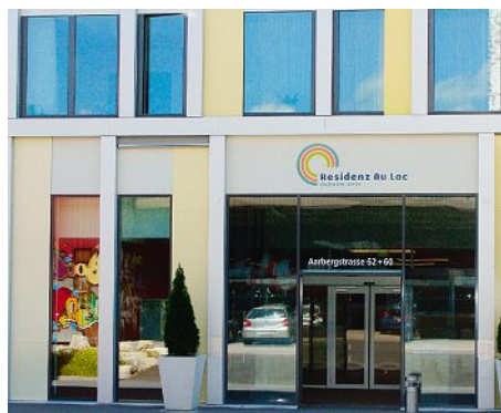
Seiteneingang Residenz Au Lac. Fassadenlösung CW 50 Pfosten-Riegel-System mit Dehnpfosten und Ansichtsbreite von 50 mm.
