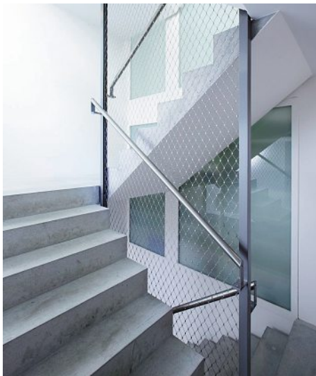
Als Absturzsicherung in einem Treppenauge. En tant que protection antichute dans une cage d'escalier.
