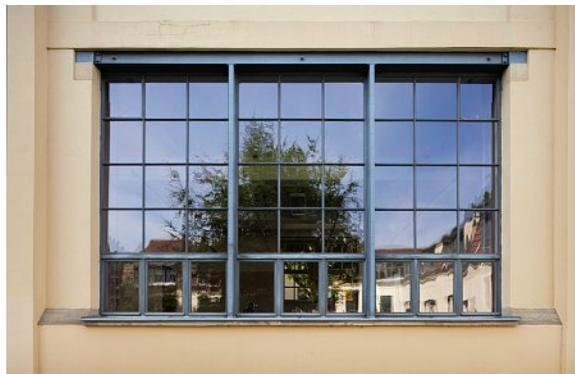
Durch die Ausstattung mit Restaurierungsglas von SCHOTT wirken selbst die Scheiben authentisch. Gleichzeitig erfüllen die Spezialgläser aktuelle Anforderungen bezüglich Sicherheit, Wärmedämmung und Sonnenschutz.
