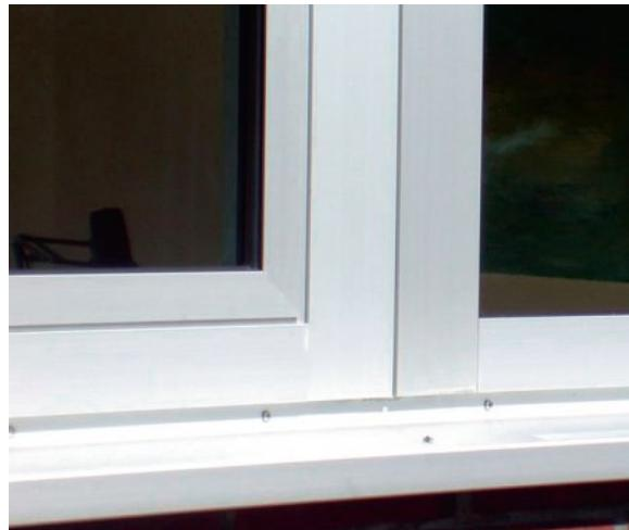
Die Flächen müssen laut Fachregelwerk im Außenbereich aus fünf Metern Abstand unter üblichem Betrachtungswinkel bei diffusem Licht, ohne direkte Sonneneinstrahlung oder künstliche Beleuchtung betrachtet werden.
