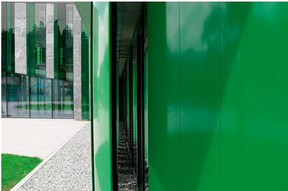
Lamellen im geschlossenen Zustand. Bei Bedarf können von den Gebäudenutzern auch manuelle Einstellungen vorgenommen werden.
