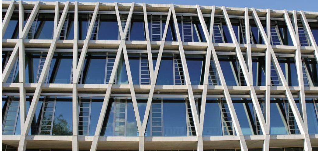
Wie bei einem Baum «wachsen» die Tragpfeiler aus Beton aus einem Stamm und verzweigen sich in den verschiedenen Etagen.
