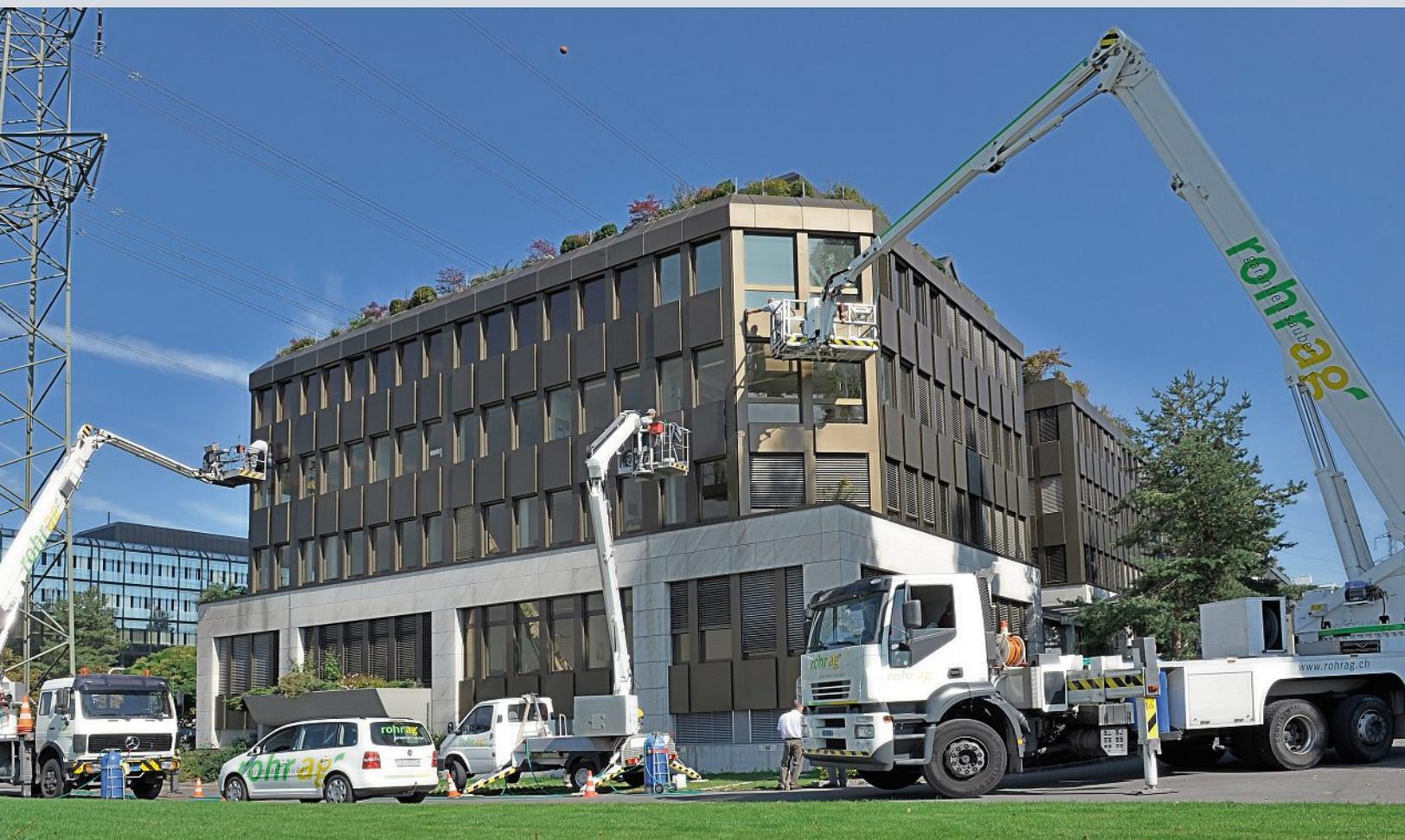
Die Rohr AG mit verschiedenen Hebebühnen und Sky Worker im Einsatz. Im Vorfeld mussten entsprechende Sicherheitsabklärungen wegen den Starkstromleitungen getätigt werden.
