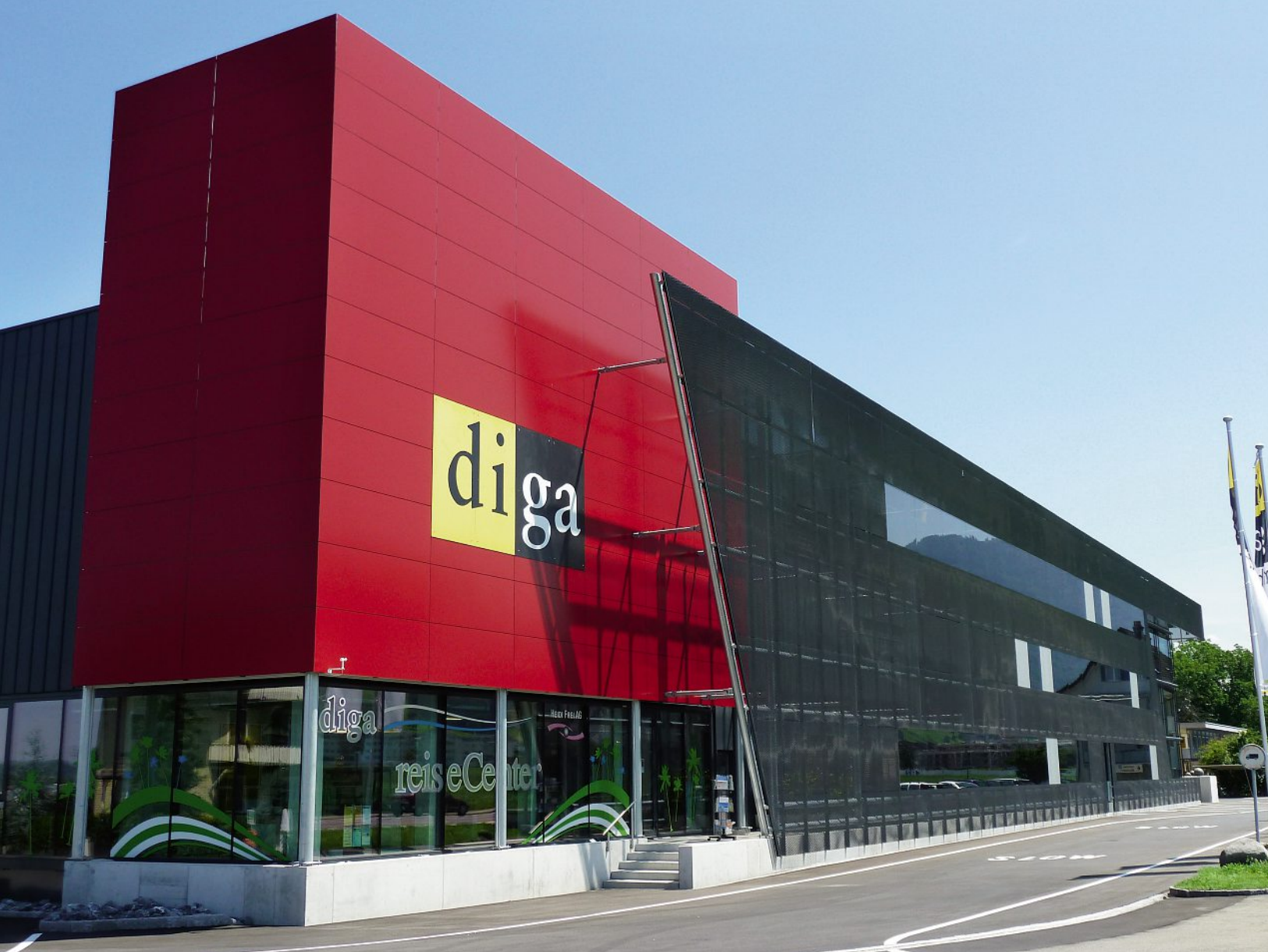
Ein offensichtlich gelungenes Facelifting für das drei Jahrzehnte alte Gebäude. Un rajeunissement visiblement réussi pour ce bâtiment vieux de plus de trente ans.
