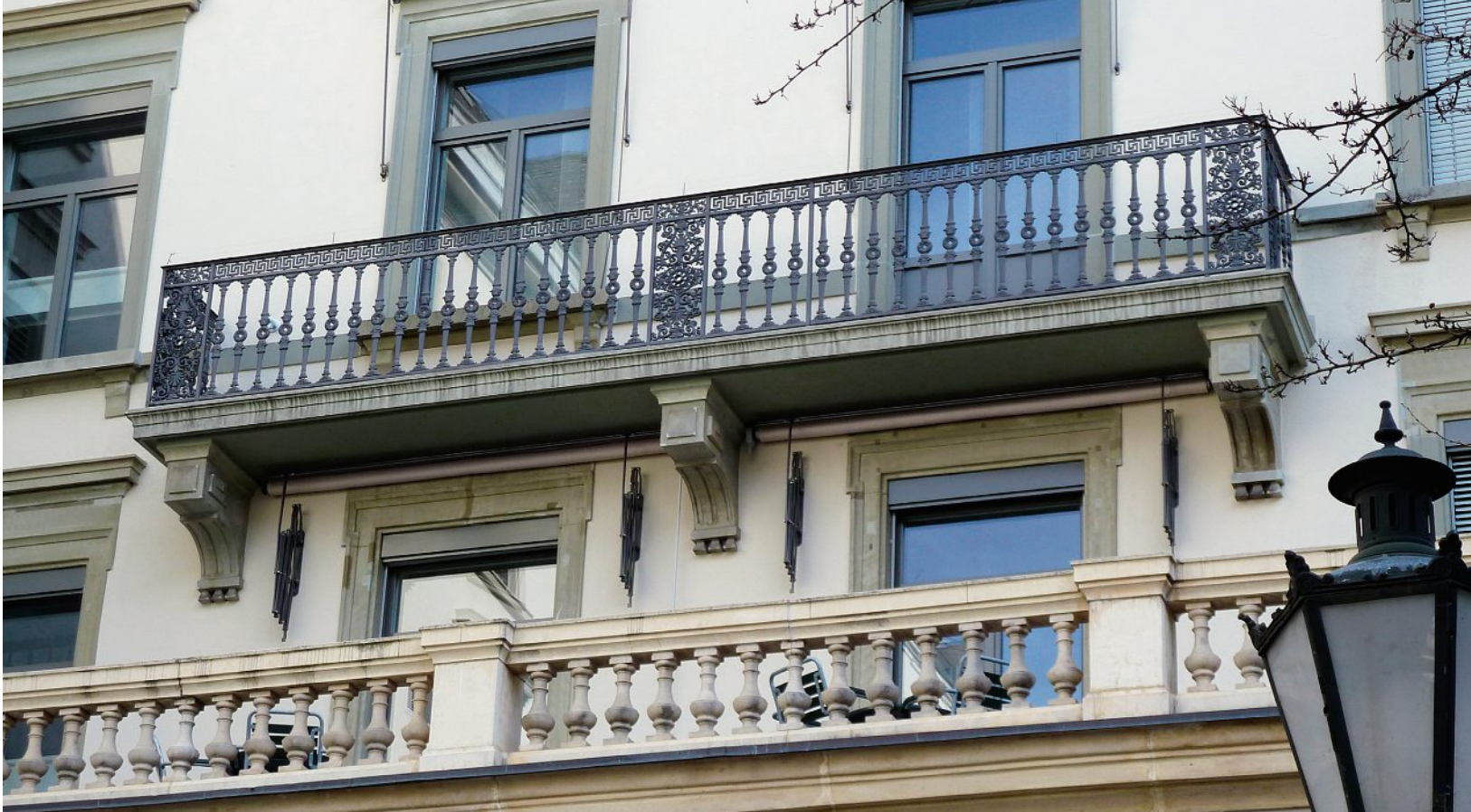
Ein rekonstruiertes Gussgeländer an der Fraumünsterstrasse in Zürich. Die schlichte Erscheinung ist auf die regelmässige Anordnung der Vertikalstäbe zurück zu führen. Une balustrade en fonte reconstruite à la Fraumünsterstrasse à Zurich. L'apparence plutôt simple est due à la disposition régulière des montants verticaux.
