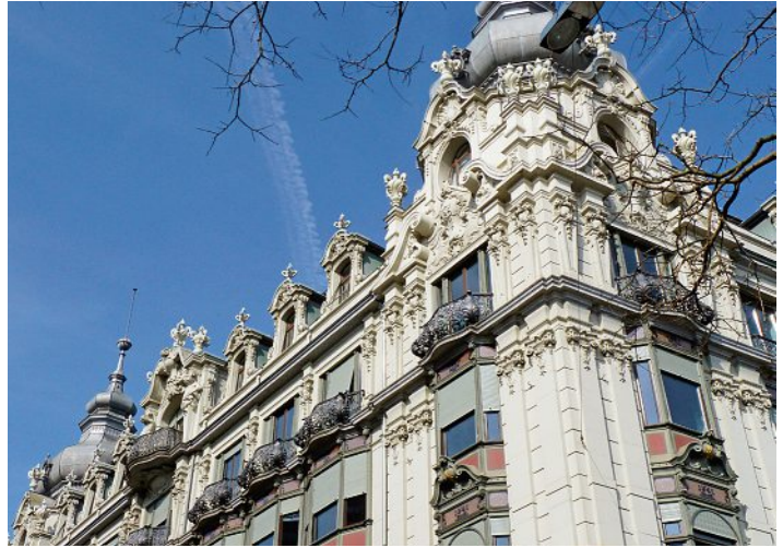
Das Metropol-Gebäude am Stadthausquai mit seiner neobarken Fassade ist eine der prägnantesten Bauten in der Zürcher Innenstadt. Die rekonstruierten Gussgeländer zieren den oberen Teil der Fassade.
