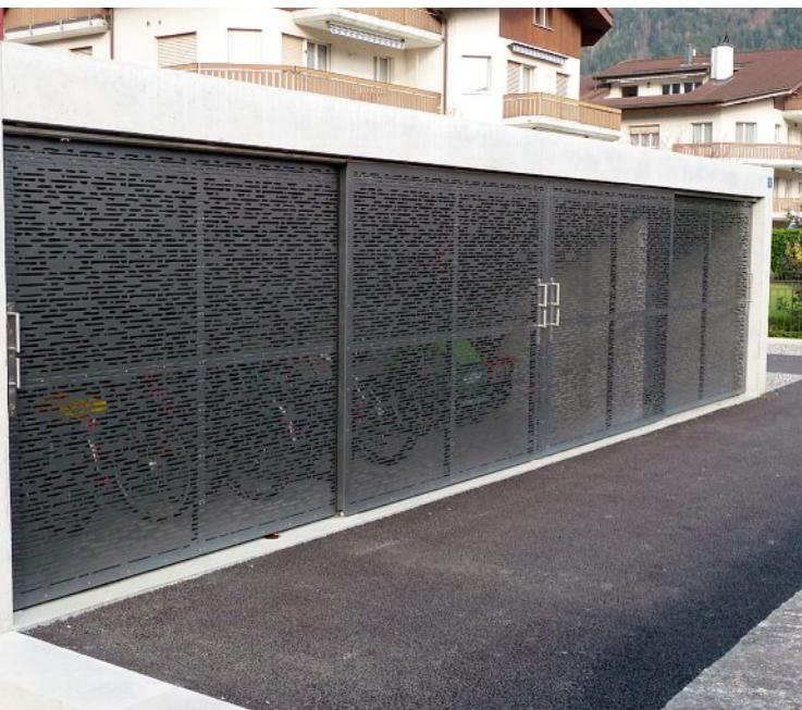
Die schiebbaren Veloraumabschlüsse sind mit gelaserten und anthrazitfarbig einbrennlackierten Aluminiumblechen verkleidet.
