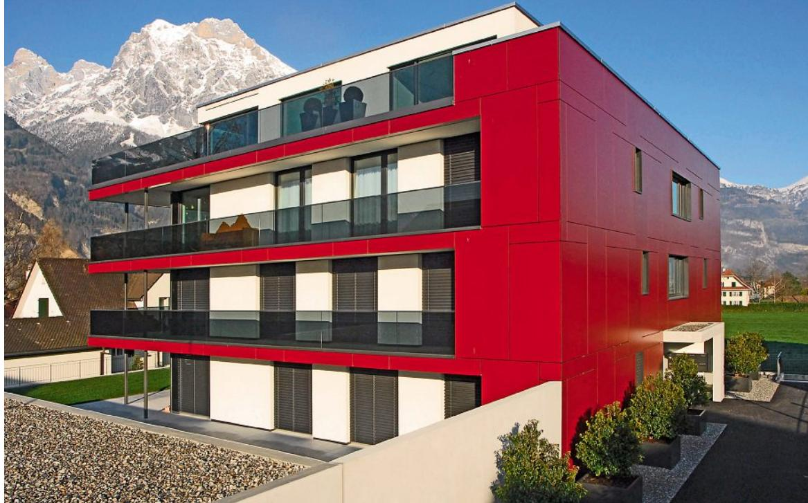
**Auf der Südwest-Seite erstrecken sich die Balkone über die ganze Gebäudebreite. Die Gläser der Balkongeländer sind nach «fail-safe» (sicher bei Versagen) dimensioniert.**
