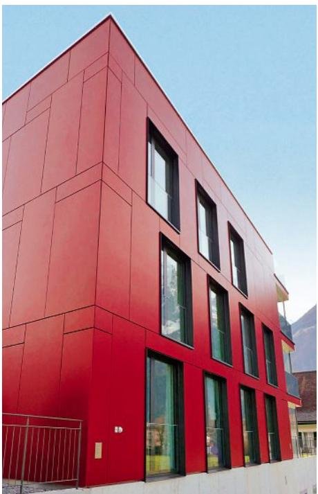
Die Nischenfenster mit ihren Blechzargen aus Aluminiumblech. Die eingesetzten Glasgeländer bilden die französischen Balkone. Die Gläser sind nach «fail-safe» (sicher bei Versagen) dimensioniert. Les fenêtres en retrait avec dormants en tôle d'aluminium. Les balustrades en verre délimitent les balcons à la française. Les vitrages sont dimensionnés selon la méthode « fail-safe » (protégé en cas de défaut).
