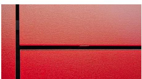
Beeindruckende Wirkung auch bei Betrachtung aus nächster Distanz. Die offenen Fugen sind 15 mm breit. L'effet produit est impressionnant, même de près. Les joints ouverts mesurent 15 mm de largeur.
