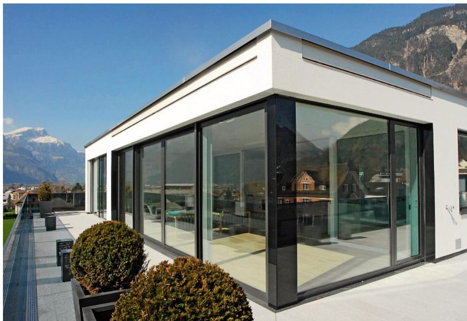
Die Verglasung im Attikageschoss: Automatisch angetriebene Schiebefenster ermöglichen ein grosszügiges Öffnen. Die Ecke ist mit emailliertem Glas verkleidet.
