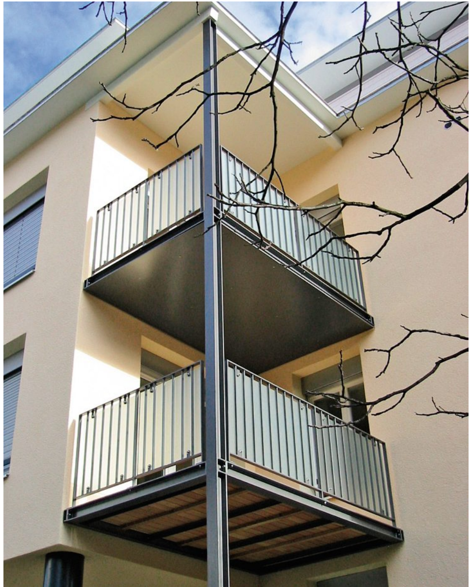
Leichtbauböden benötigen Auflageprofile in relativ engen Abständen. Das Bild zeigt den Unterschied mit und ohne Untersichtsverkleidung. Herstellung: Wolfisberg Metallbau AG, Sarnen
