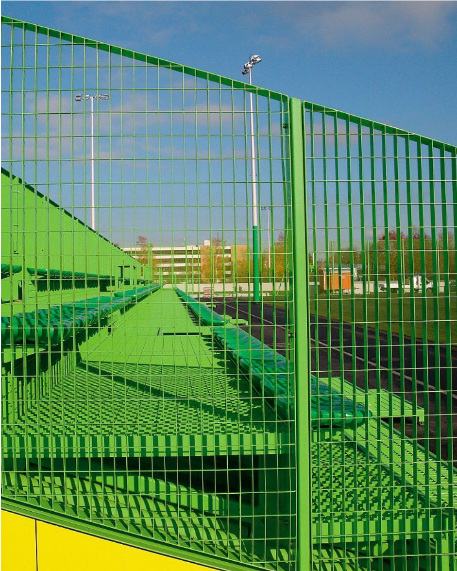
Die Einzäunung aus Gitterrosten dient als Absturzicherung. La clôture en caillebotis sert de garde-corps.
