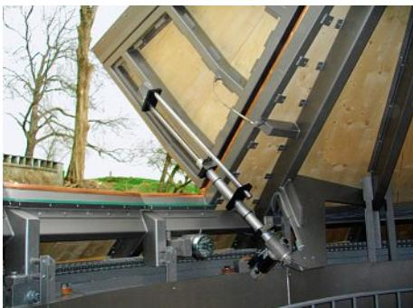
Die beiden Dachflügel öffnen sich um 90°. Eigentlich war vorgesehen, die innere Mechanik mit Blechen abzudecken. Doch die Bauherrschaft entschied sich für eine Verkleidung in Plexiglas (noch nicht angebracht), welche die freie Sicht in das Innenleben gewährleistet.
