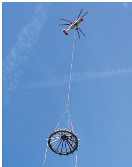
Der Transport erfolgte mit dem Kamov von Heliswiss mit einer max. Traglast von 5 t.
