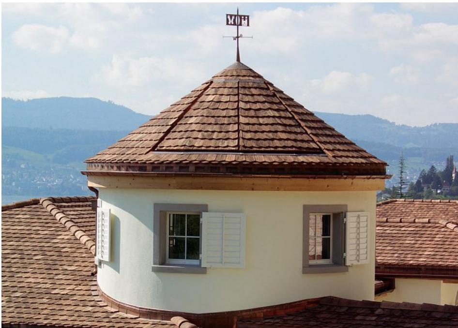
Von aussen lässt sich das aus Metall gefertigte drehbare Observatorium kaum erkennen und unterscheidet sich nicht vom Dachbild.
