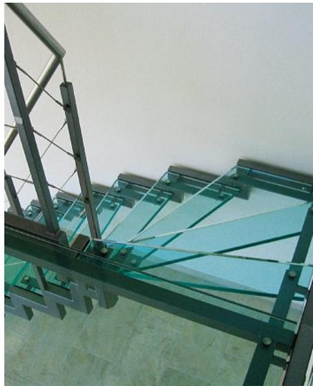
Glasstufen gewähren eine hohe Lichtdurchflutung und verlangen vom Metallbauer ein äusserst präzises Arbeiten. Seilabstände sollten eingehalten werden.
