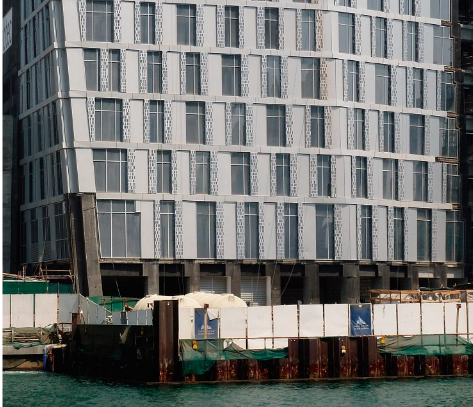
Die Fassade besteht aus Pfosten-Riegel-Elementen.
