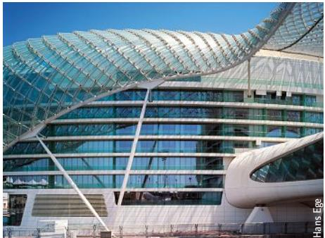
Die Stahlkonstruktion der «Gridshell» ist in wuchtigen Rohrrahmen gefasst. Die Lasten werden über zehn V-förmige Stützen auf den Boden abgetragen.
