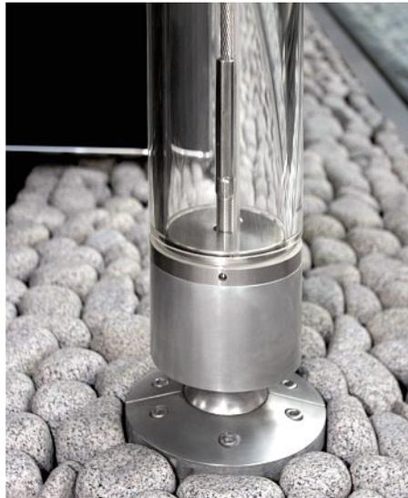
Die transparenten Stützen bestehen aus einem innen liegenden Kernrohr, das über ein besonderes Klebverfahren dauerhaft mit einem segmentierten Hüllrohr verbunden ist. Ein vorgespanntes Drahtseil gewährt auch bei einer allfälligen Entlastung einen permanenten Druck.
