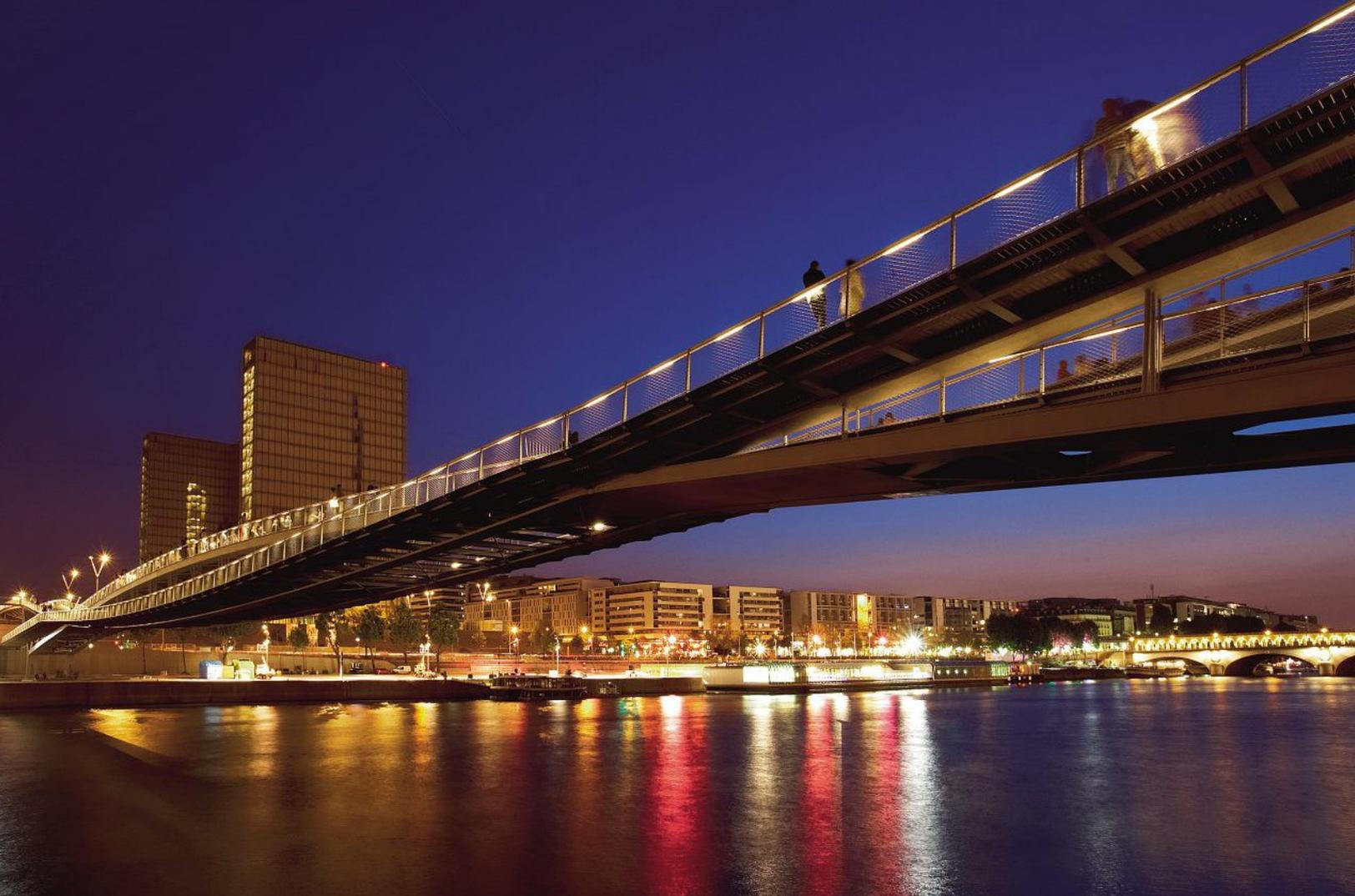
Die Brückenkonstruktion überspannt einen aussergewöhnlich breiten Flusslauf stützenfrei auf einer Länge von 194 Metern.
