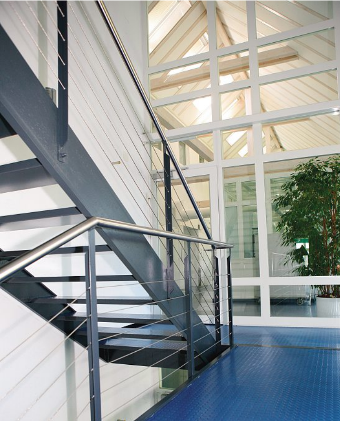
Die INOX-Drahtseile wirken leicht, trennen die Räume optisch nicht und stören den gestalterischen Ausdruck kaum.
