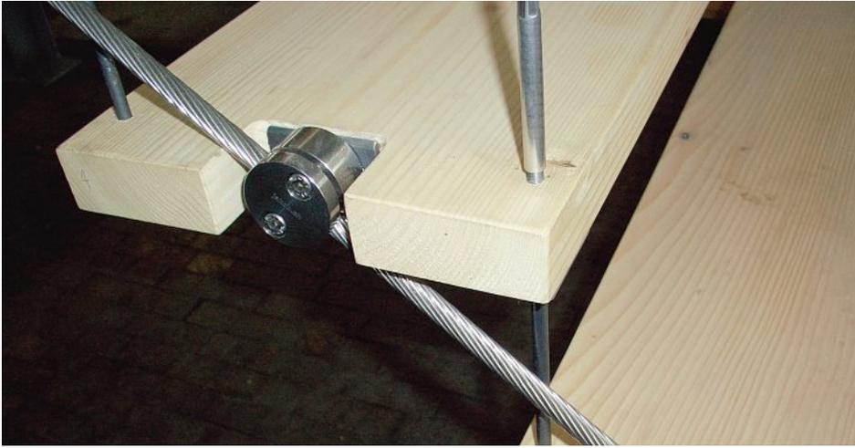
An den eleganten Seilhaltern sind stählerne Auflegewinkel angeschraubt. Der Rundstahl mit unterer Auflageplatte stabilisiert und nimmt die vertikalen Spannseile des Geländers auf.
