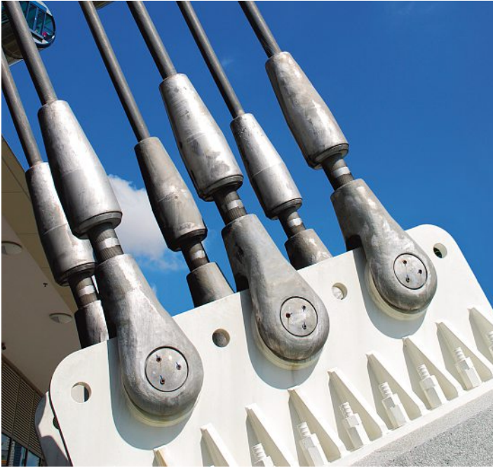
Verankerung der Stabilisatoren.
