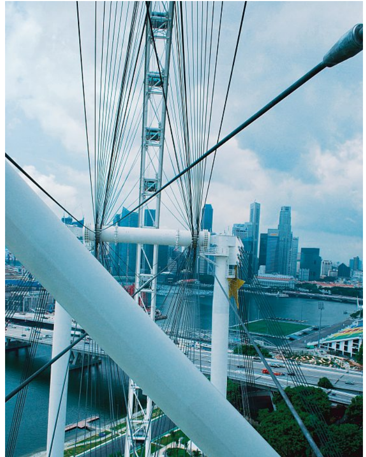
Die Stahlstützen, welche das Rad halten, sind 85 m hoch und haben einen Durchmesser von 2,8 m. Sie werden durch schräg an den Boden gespannte Stahlkabel von 10 cm Durchmesser stabilisiert. Les piliers en acier qui portent la roue font 85 m de haut et 2,8 m de diamètre. Ils sont stabilisés par des câbles d'acier obliques de 10 cm de diamètre depuis le sol.
