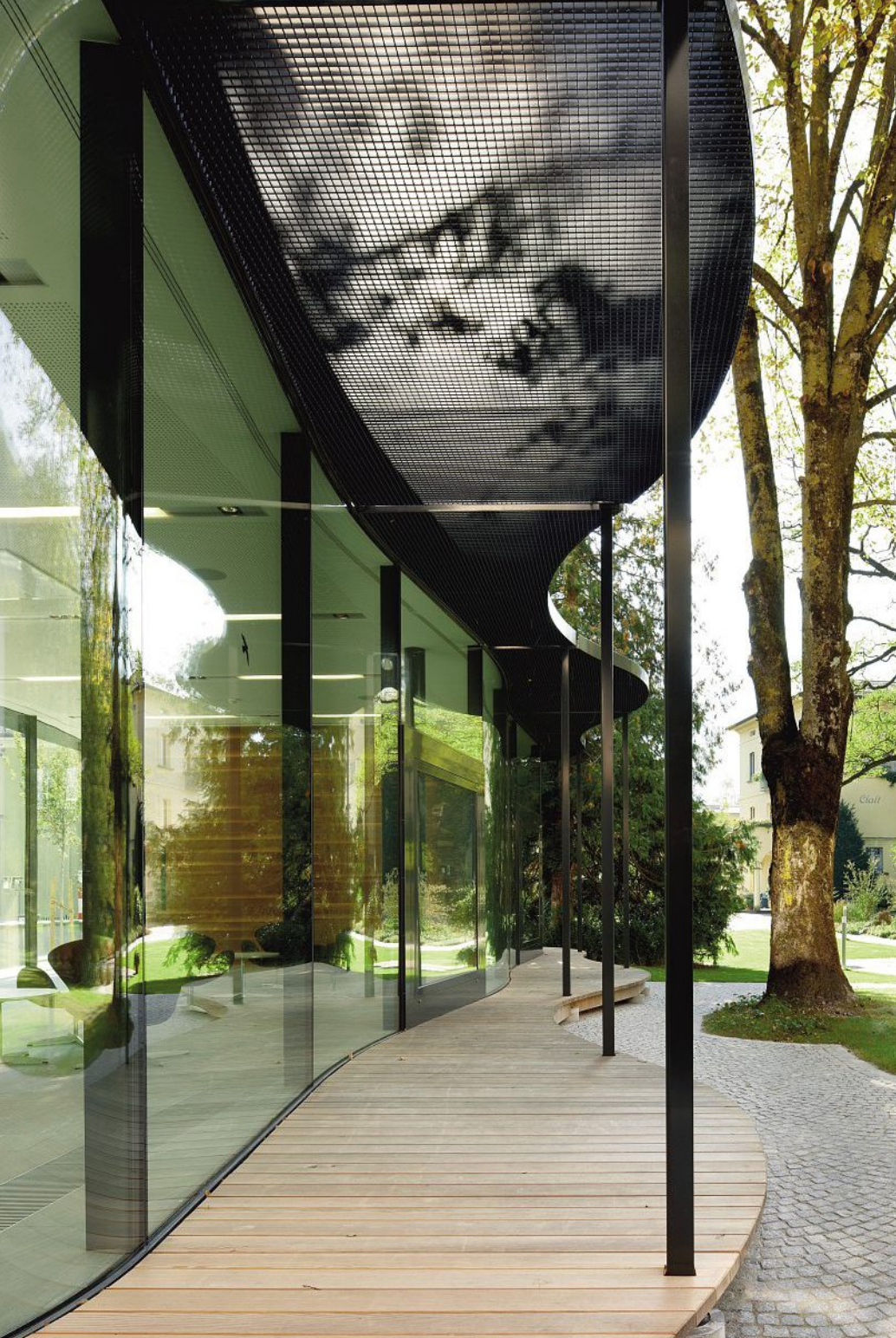
Glas in gewellter Form über die ganze Höhe. Die Vertikalstösse sind mit SSG-Fugen gelöst. Du verre ondulé sur toute la hauteur. Les jointures verticales se présentent sous forme de joints VEC.
