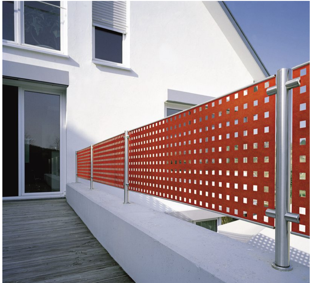
Geländer mit Lochblech aus COR-TEN. Balustrade en tôle perforée COR-TEN.
