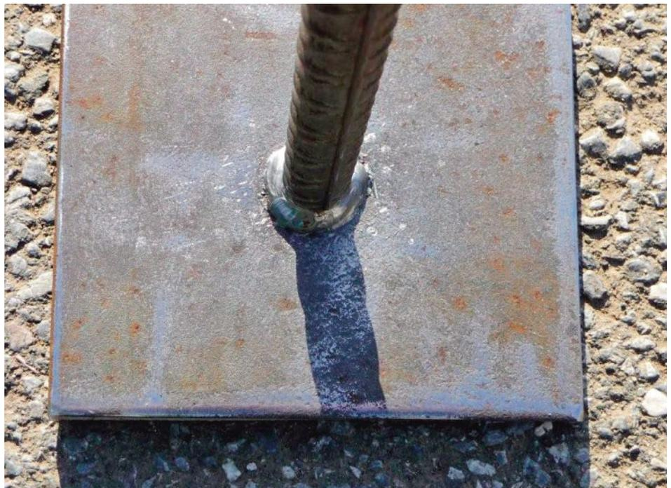
Für die Stirnplatte muss geprüftes Material verwendet werden, für das Anschweisst des Betonstahls muss die Firma die Eignung nachgewiesen haben.
