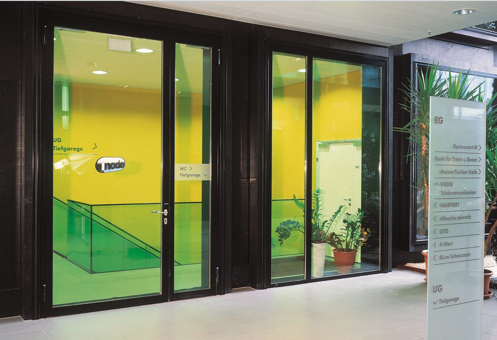
Brandschutz-Profilsystem Janisol C4 zur Absicherung des Fluchtwegs.
