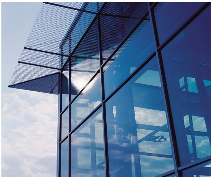
Ab sofort erreichen sämtliche COMBI-Isoliergläser einen Ug-Wert von 1,0 W/m<sup>2</sup>K (nach EN 673).
