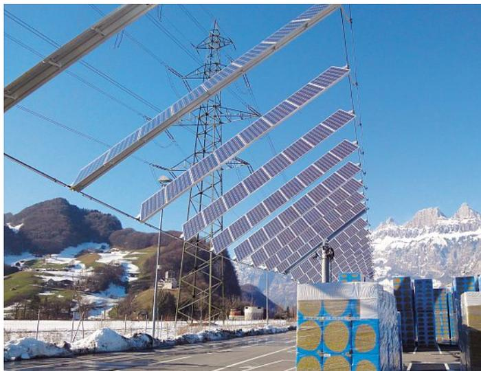
Die Solar Wings schweben 8 Meter über dem Flumroc-Logistikareal und werden automatisch dem Sonnenlicht nachgeführt.
