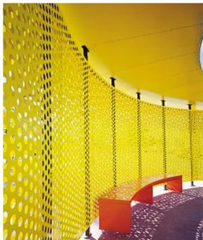
Pavillon: Rundlochung versetzt (Sonderlochung), Stahl, Blechstärke 1,5 mm, nachträglich pulverbeschichtet.
