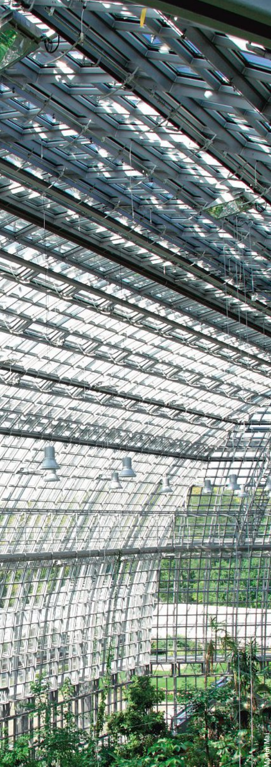
Überspannte Stahlbogen halten die gewölbte Fassade. Des poutres cintrées maintiennent la façade arrondie.
