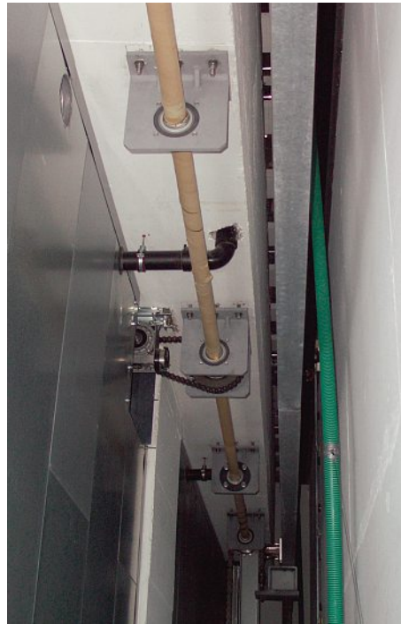
Blick vom Schacht: Die Antriebswelle mit Zugkette und Elektromotor.
