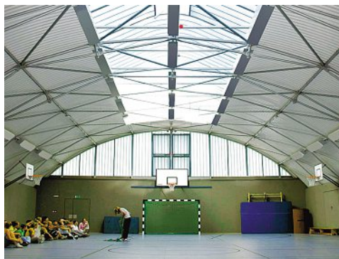
Lichtbandsystem mit Lichtfassade Grillodur® GD/G zur Sporthallenbeleuchtung.
