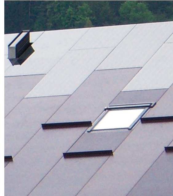
Detaillansicht der Dachfläche: mit integrierten Dachfenstern und Schneefang.
