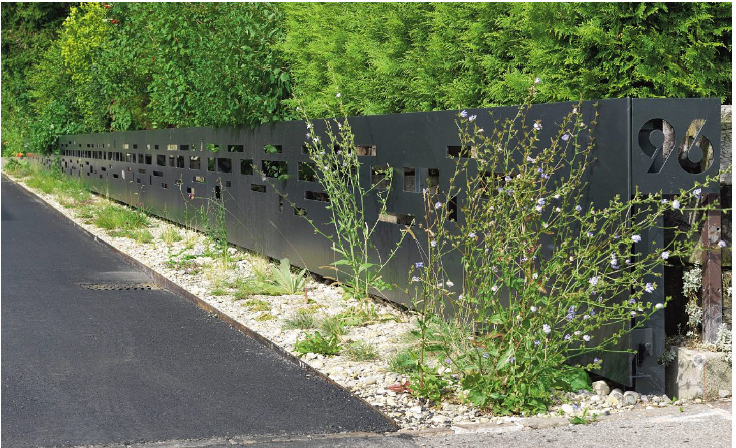
Die Grenzbande aus lasergeschnittenem Stahlblech. (Hergestellt durch Acklin Metallbau AG, Zug).
