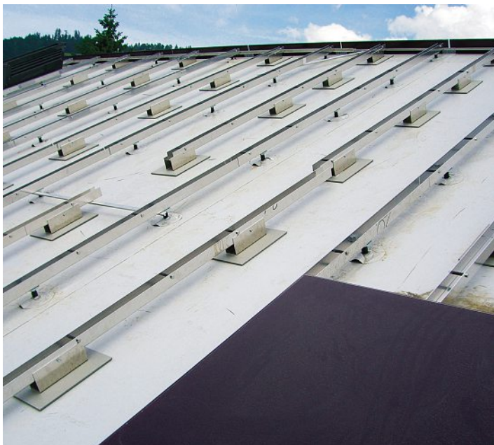
Einhängekonstruktion aus U-Schienen mit Haltebolzen auf dem Dach. Construction suspendue à base de rails en U avec boulons de fixation sur le toit.
