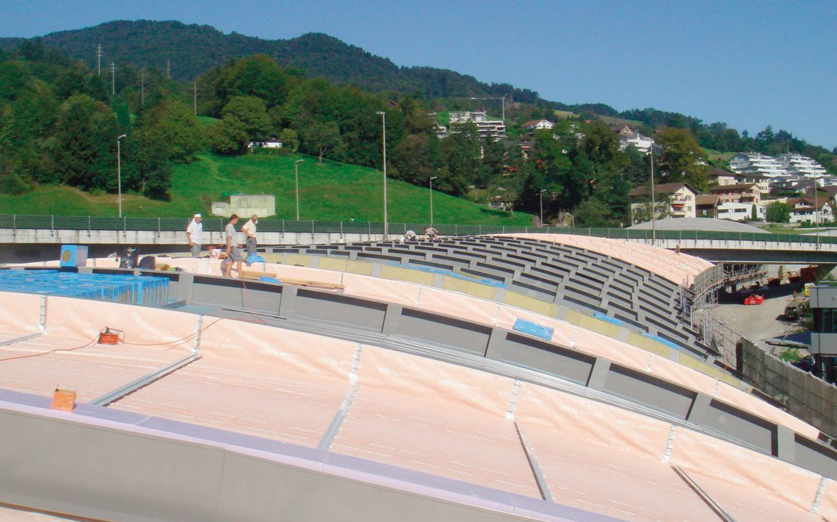
Die Eleconstruct & Partner AG verlegte rund 30 000 m 2 Blech über der Autobahn in Hergiswil. Eleconstruct & Partner AG a posé environ 30 000 m 2 de tôle au-dessus de l'autoroute à Hergiswil.
