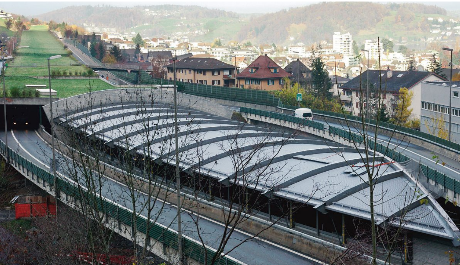
Die Rippen des Stahlbaus prägen die Dachstruktur. Die Profilbleche weisen alle unterschiedliche geometrische Formen auf.
