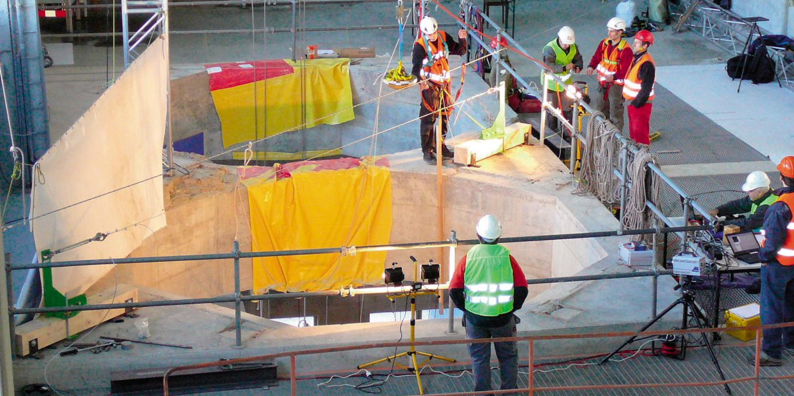
Zertifizierung der Pfostensysteme in Wildegg AG
