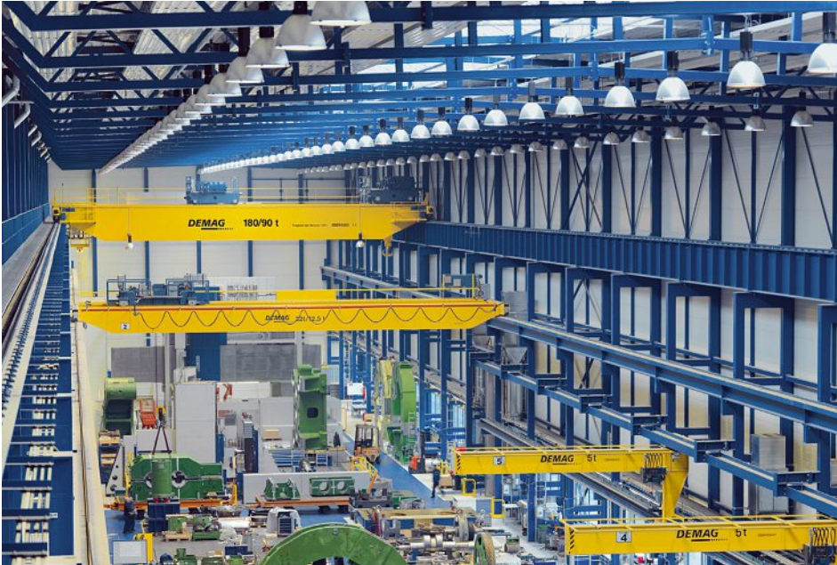
Konsolkranen in der dritten Ebene übernehmen Transportaufgaben und unterstützen bei Montagearbeiten.
